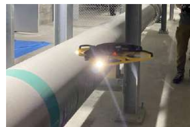
ドローンを活用した設備点検
